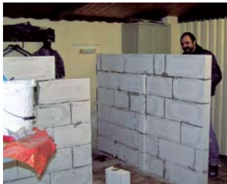
Thomas Schuster beim Mauern
