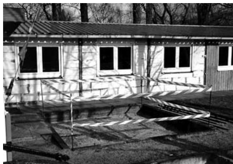
Die Wände sind ausgemauert und die Fenster eingesetzt
