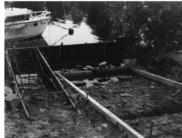
Die Slipanlage im Bau
