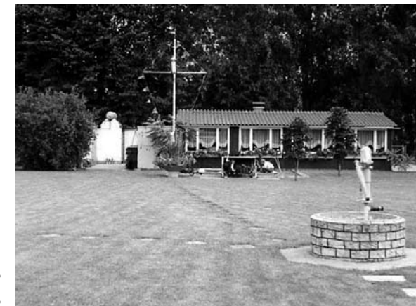
Vereinsheim ohne Toilettenanlage
