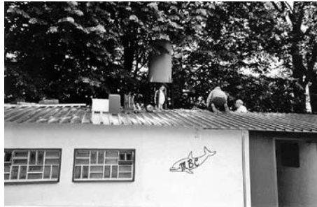
Das Dach wird gedeckt
