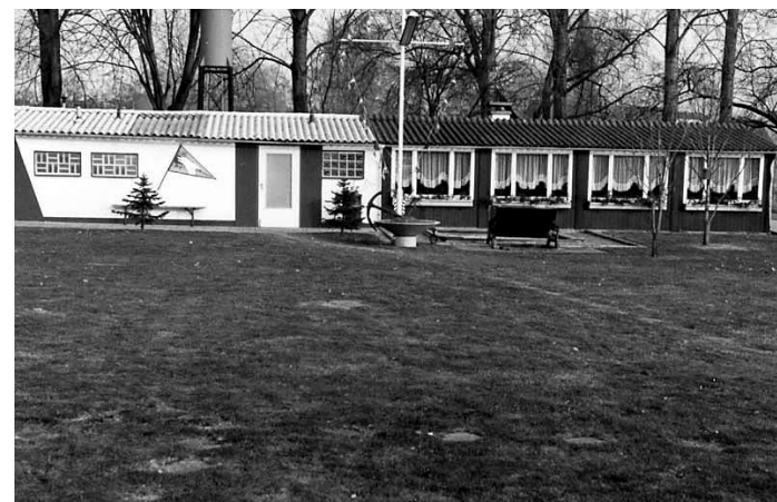
Später wurde der Toiletten- und Duschraum angebaut. Der Tank auf dem Dach diente zur Wasserversorgung
